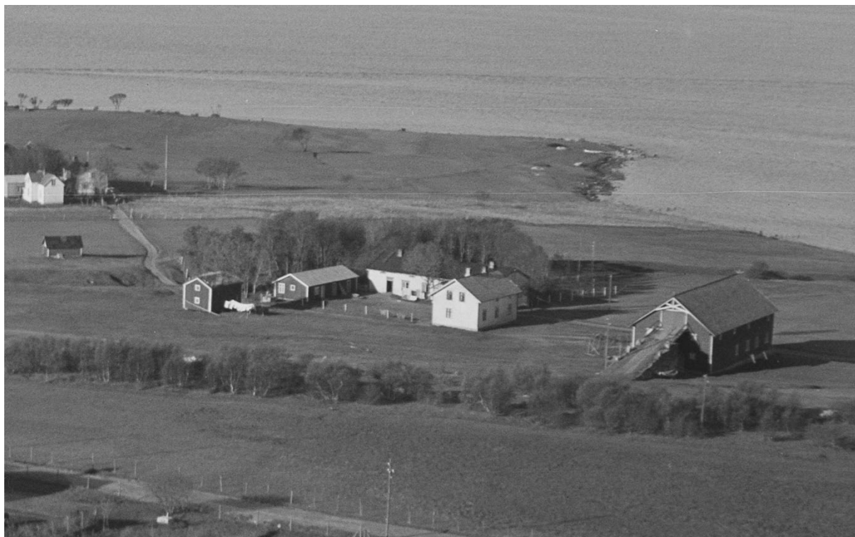
Figur 3. Alstahaug prestegård ca. 1940. Foto: Mittet og co. Vi ser tydelig Bekkedalen som gikk ned til havet. Brocks gård til venstre i bildet.
